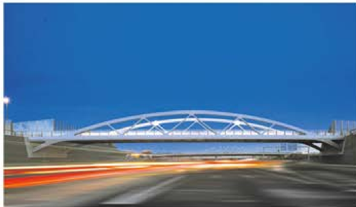
Bogenfachwerk mit Gehwegbeleuchtung in der Dämmerung © Hajo Dietz
