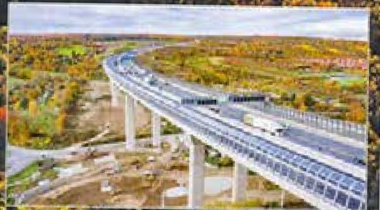
Talbrücke Heidingsfeld vor der Fertigstellung
